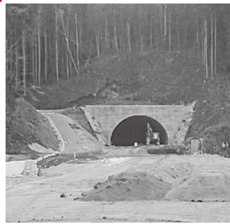
気仙町に貫通したトンネル
