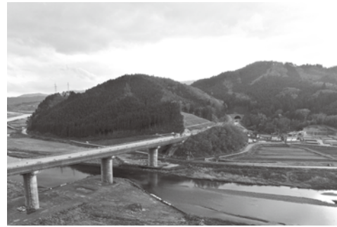
工事が進む三陸沿岸道路
