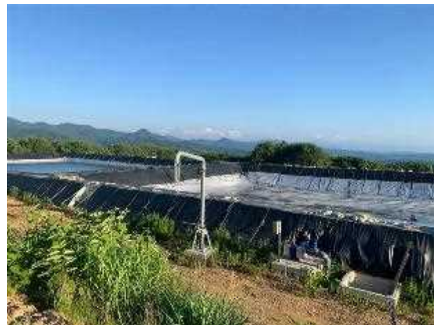
消化液貯留槽
