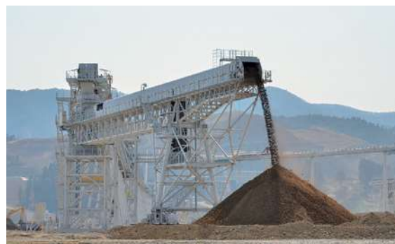
ベルトコンベアが本格稼働
